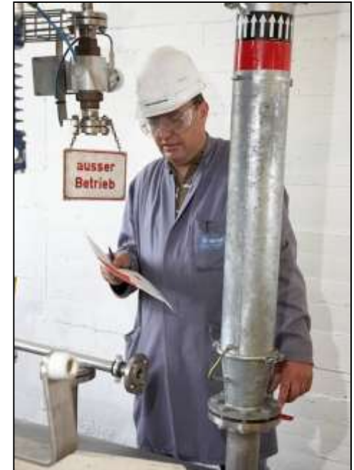
Kontrolle der Maßnahmen durch den Aufsichtsführenden
